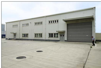
Werksgelände in China
